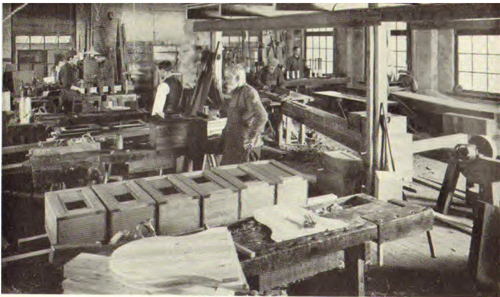
Del av snickeriverkstaden Fabriksgränd 1, Sundbyberg, år 1922
